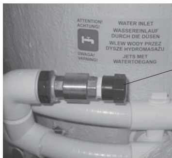
Påfyllningsanslutning med skyddslock 1/2"
